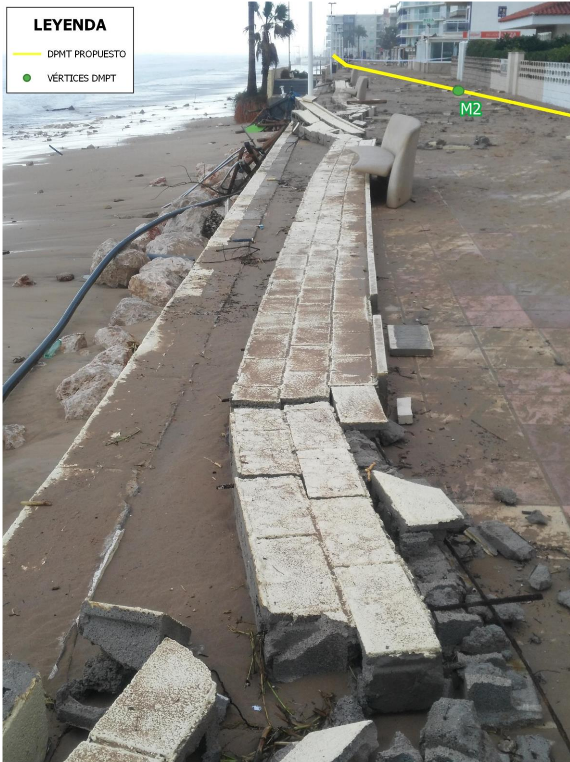
Fotografía 1. Daños producidos por el temporal “Gloria” en el tramo norte de la costa del municipio de Bellreguard (Valencia).
