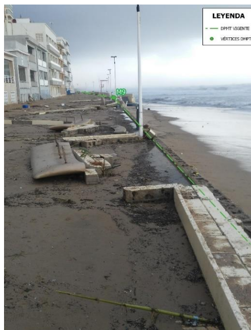
Figuras 16 y 17. Daños producidos por el oleaje del temporal “Gloria” en el paseo marítimo de Bellreguard (Anejo nº 3).
